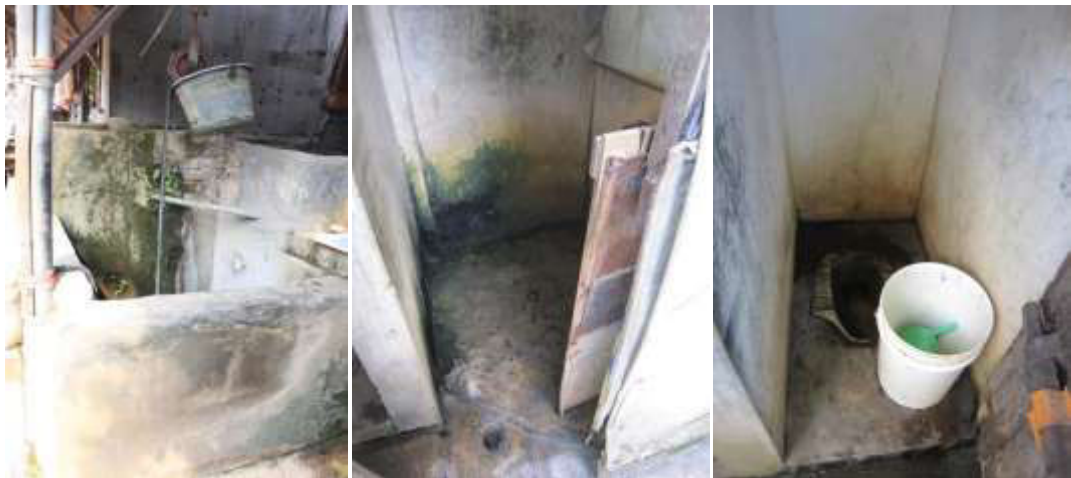
Gambar 18. Kondisi Toilet Umum (b)
