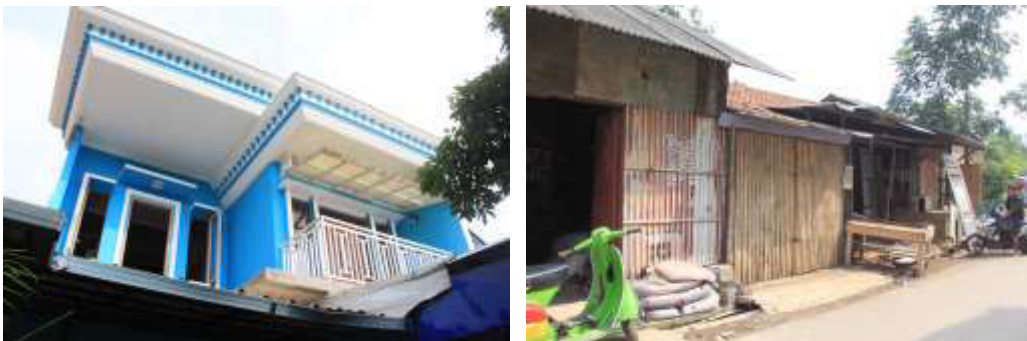
Gambar 17. Bangunan permanen dan temporer
