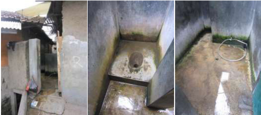
Gambar 17. Kondisi Toilet Umum (a)
