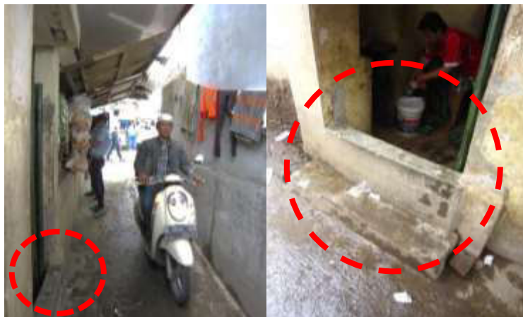
Gambar 22. Penambahan ketinggian lantai pada muka pintu rumah
